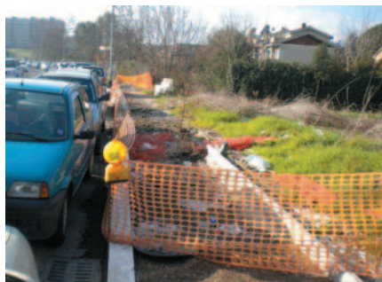
Via di Mezzocammino - I lavori... fermi da mesi!
